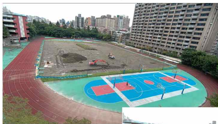
足球場施工中 (既有草皮及土層挖除運棄)
