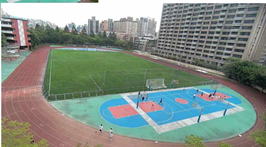
足球場施工完成
